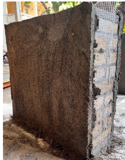
b) Hoàn thiện lớp trát 15mm
