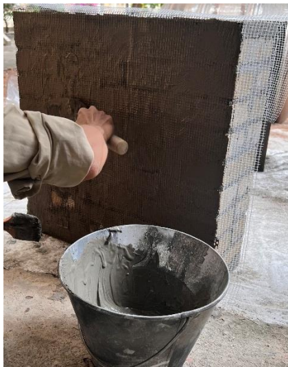
a) Thi công lưới GFRP
