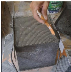
b) Thi công lưới
