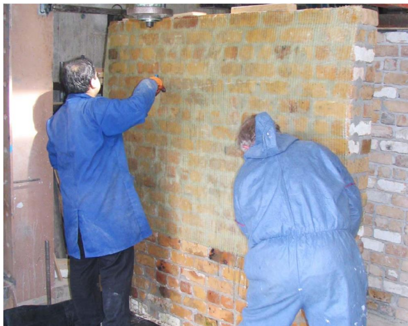
Hình 1. Gia cường lưới sợi thủy tinh trên khối tường [4].
